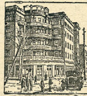
На снимке: Новый 85-квартирный дом Ростов на Дону для волеводч Донского речного хозяйства.
