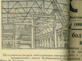
На строительство цеха металлообработки конструкции механического завода Кулбаевского горнопромышленного комбината Фого Н. Славина.
