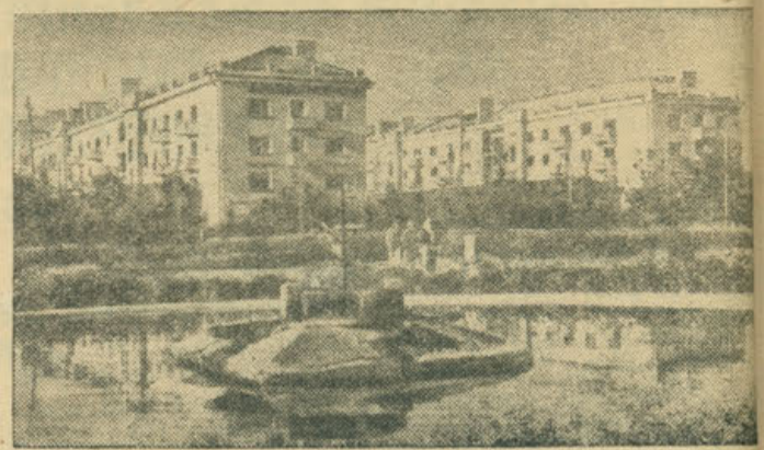
Жилые дома рабочих Криворожского металлургического завода (Кривой Рог, СССР). Фото К. Инсарова.
