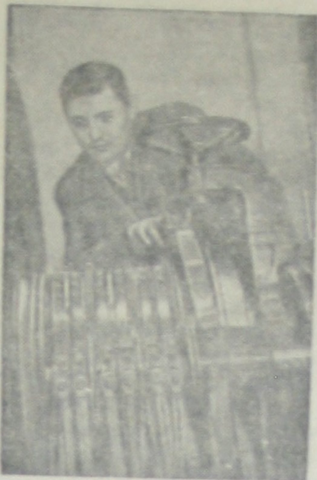
Механик литейного цеха судостроительного завода имени Жданова (Ленинград) С. С. Лемберг предложил введение электродуговой плавки на предельной мощности, увеличив загрузку тигля. Внедрение предложения тов. Лемберга дало большую экономию электроэнергии. Из снимка: С. С. Лемберг осматривает траверс агрегата плавильной печи.
