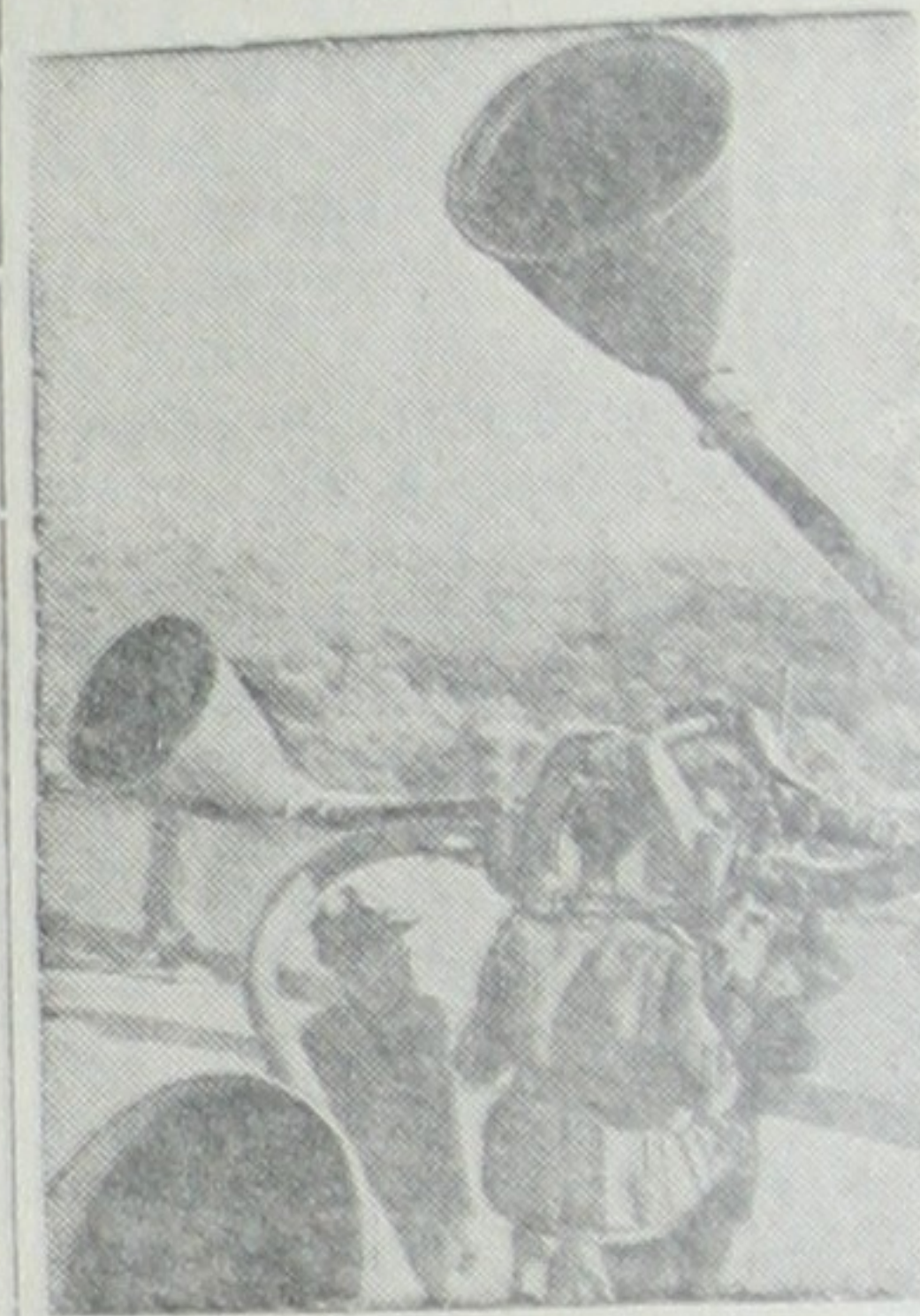
Итальянский звукоуловитель, установленный близ Неаполя (Италия).
