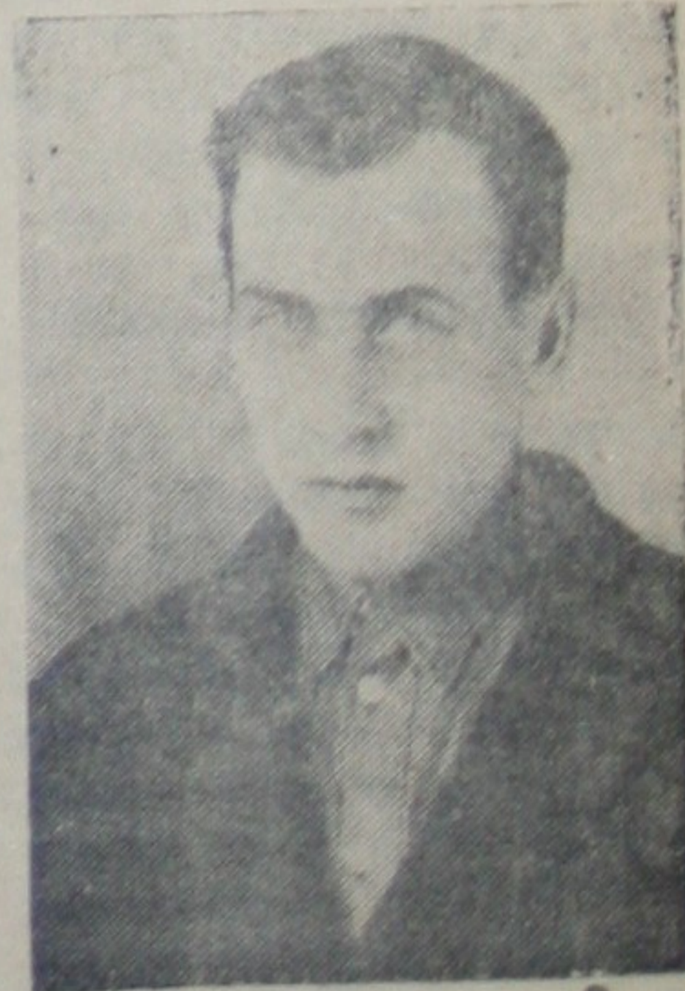
Одна из передовых бригад плотников 6-го района строительства тов. Алюхина план ноября выполнила на 246 проц. В начале декабря бригадир т. Алюхин и члены его бригады выдвинули инструкторами производственного обучения. На снимке: А. А. Алюхин.
